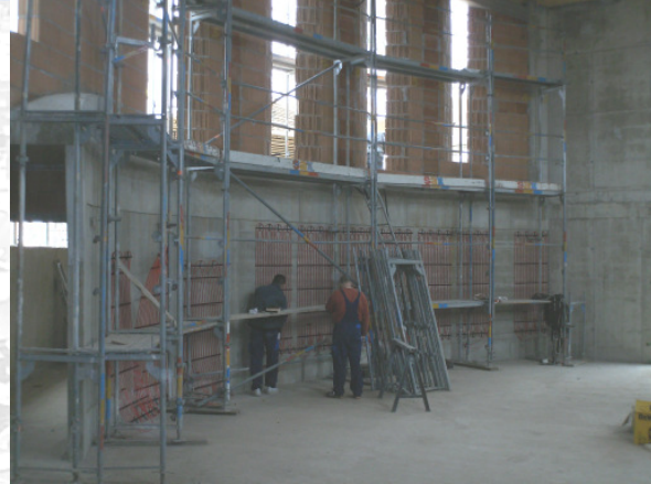
wandheizung als zusatzheizfläche bei fehlender heizlast
